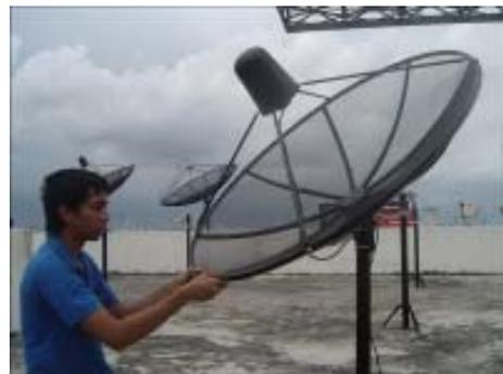
ลองเปลี่ยนช่องไปที่ FTV INDIA ดูว่าภาพกระตุกหรือไม่ หากมีอาการกระตุก แสดงว่าหน้าจานดาวเทียมยังไม่ตรงตำแหน่งดี ซึ่งต้องทำการปรับละเอียด เกี่ยวกับมุมก้มเงย และมุมสายอีกครั้ง
