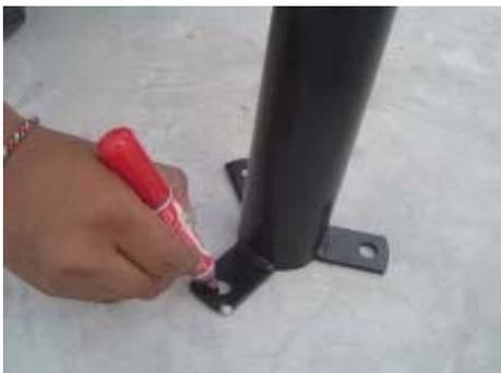
ให้ใช้ปากกาทำตำแหน่งให้ชัดเจน (ข้อควรระวัง จะต้องทำตำแหน่งให้ตรงจุดนี้ เพราะหากทำตำแหน่งคลาดเคลื่อนทำให้การติดตั้งไม่แข็งแรง)
