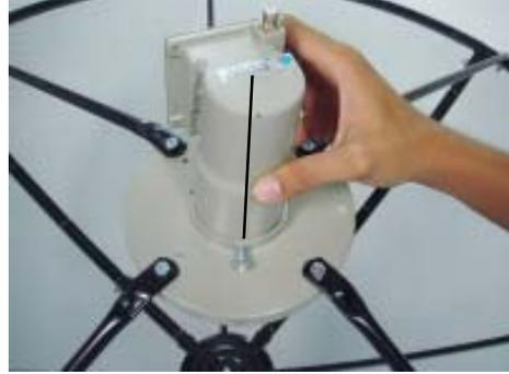
นำ LNB มาใส่กับสกาลาริง โดยให้เส้นที่ขีดไว้อยู่ตรงกลางตำแหน่งสกูรี่ LNB
